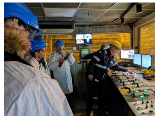
Au cœur du poste de contrôle de l'usine Winoa
